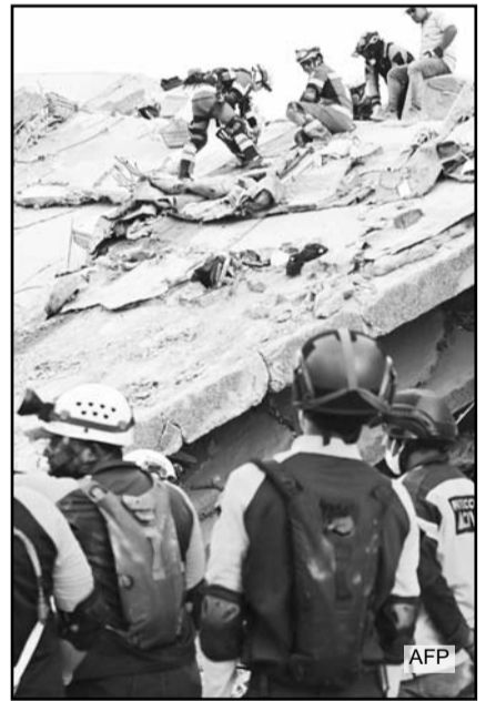
Rescatistas permanecen sobre los escombros de un edificio colapsado durante las labores de búsqueda en Catia La Mar.
