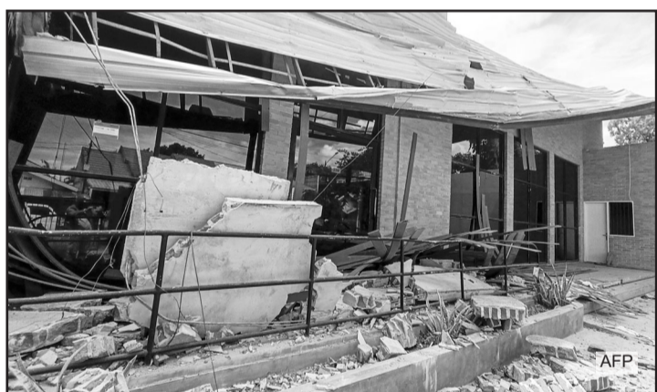
Edificio dañado tras un sismo de magnitud 6.7 registrado el 16 de junio de 2026 en Palu, Sulawesi Central, Indonesia.
