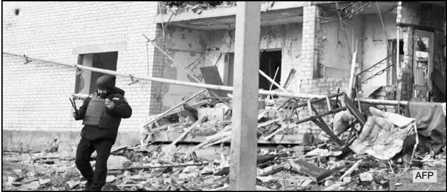
Agente del orden ucraniano camina entre los escombros de un edificio residencial dañado tras un presunto ataque aéreo.
