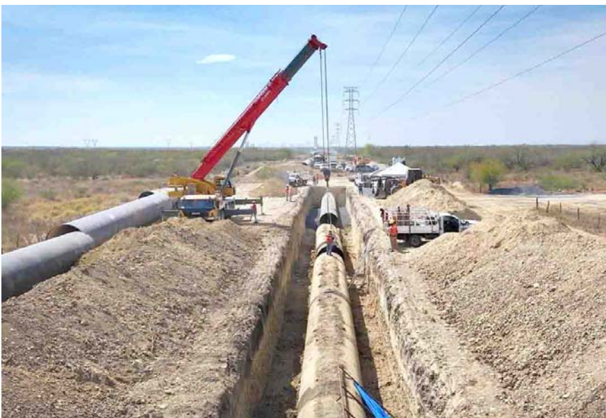
“Los trabajos de reparación del Acueducto Cuchillo I se llevan a cabo con personal y maquinaria propia de Agua y Drenaje”
