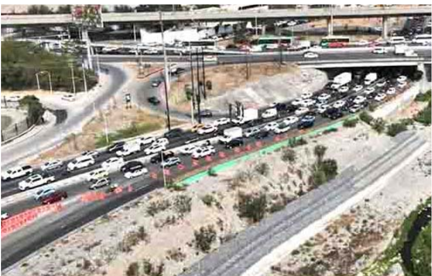
Debido a los trabajos de la Línea Cuatro del Metro se tuvo que suspender de manera parcial la circulación por los carriles expés
