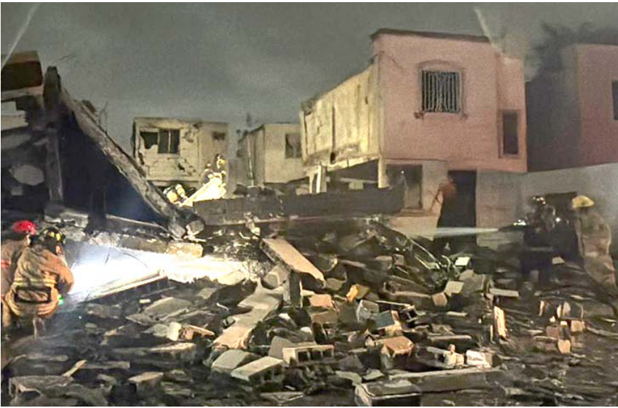
Al momento continúan labores de remoción de escombros.
