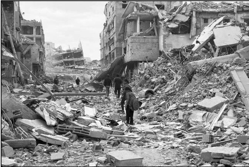
Ruinas y escombros en una calle de la ciudad de Gaza.
