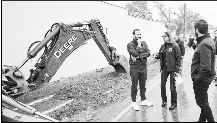
El alcalde Mauricio Farah supervisó las obras.
