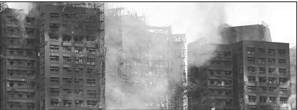
La zona continúa acordonada ante el riesgo estructural.
