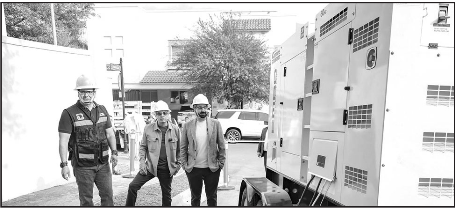
Son plantas móviles de energía, diseñadas para restablecer temporalmente el suministro mientras la CFE realiza las reparaciones definitivas.
