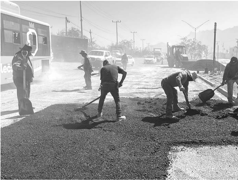
Las cuadrillas de la Secretaría de Servicios Públicos aplicaron 21 toneladas de carpeta asfáltica.
