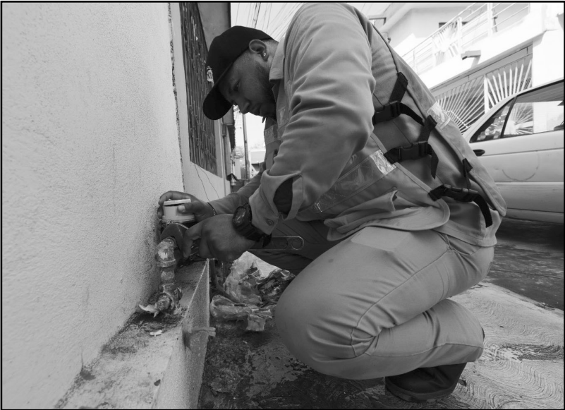
Con eso se tiene ya un avance del 50 por ciento de los medidores
