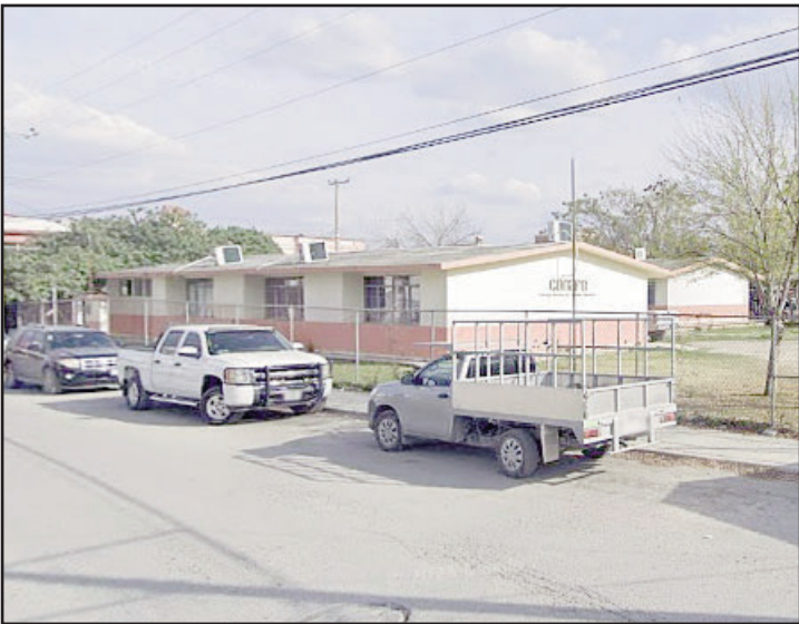
Robaron equipo de cómputo, cableado y materiales.
