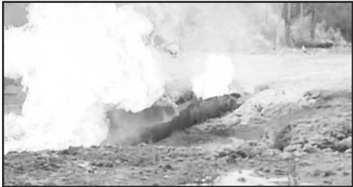
Reportan explosión de ducto propiedad de Pemex en Chiapas
