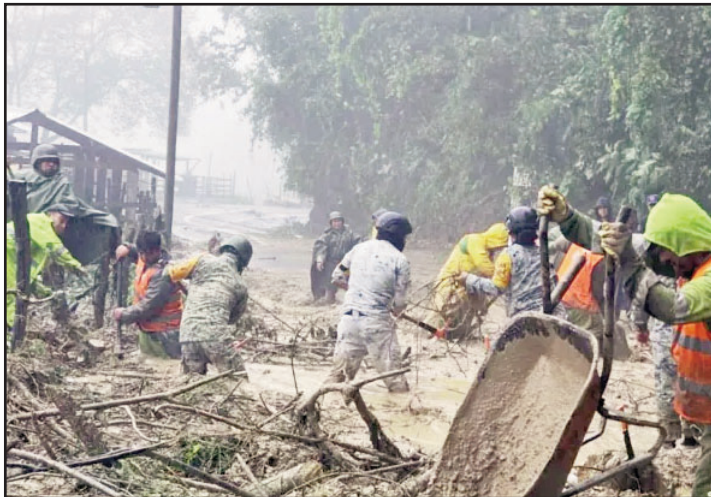
Autoridades y ciudadanos ayudan a limpiar los daños.
