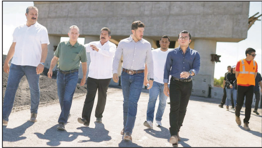
La construcción tiene un avance del 90 por ciento.
