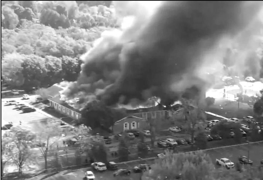
El incendio provocado redujo a cenizas el edificio religioso, considerado ahora una pérdida total.
