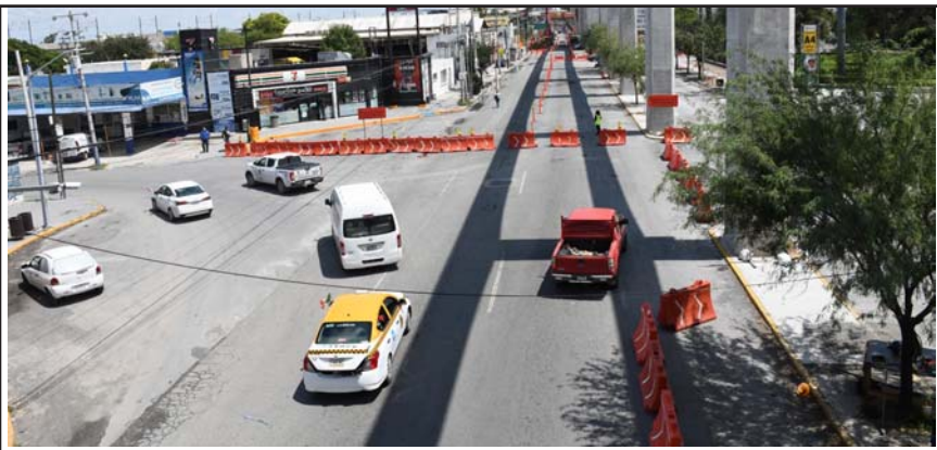
Se implementó ante las obras del Metro que están en ese cruce.
