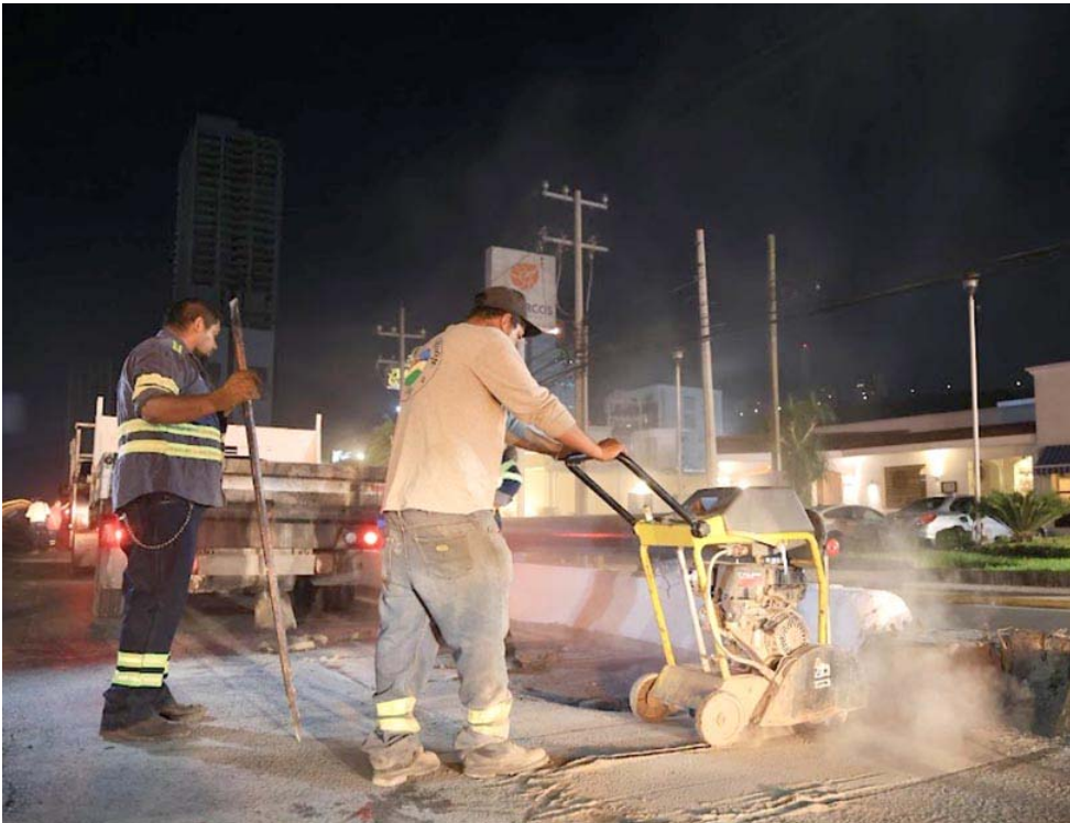
Se ejecutaron acciones de bacheo, raspado y lavado de tubos y muros, pintura tanto en muretes como la raya amarilla en cordones.
