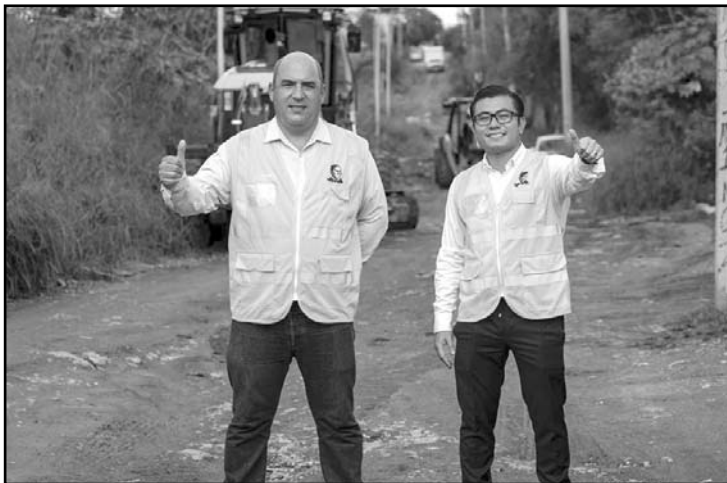
El alcalde Félix Arratía Cruz inició obras de pavimentación de la calle Valle de Jamaica, ubicada en la zona conocida como “El Pozo”.
