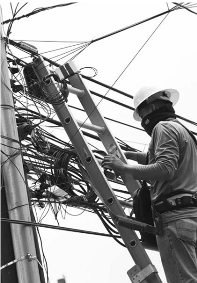
La meta es eliminar al menos un millón de metros lineales de cableado que no se utiliza. tiparon en el operativo de esta semana. Monterrey fue uno de los primeros municipios en implementar el programa desde las pasadas administraciones que encabezó Adrián de la Garza, recordó Marcelo Segovia, Secretario de Administración municipal. Por su parte, la secretaria de Servicios Públicos, Mayela Quiroga, reiteró que el proyecto es estar llevando a cabo estas acciones dos días por semana de manera conjunta con las empresas en el lapso de 10:00 a 16:00 horas. (JMD)
