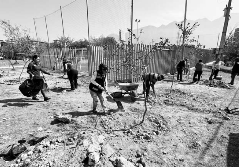
Cuadrillas de servicios públicos se dieron a la tarea de limpiar
