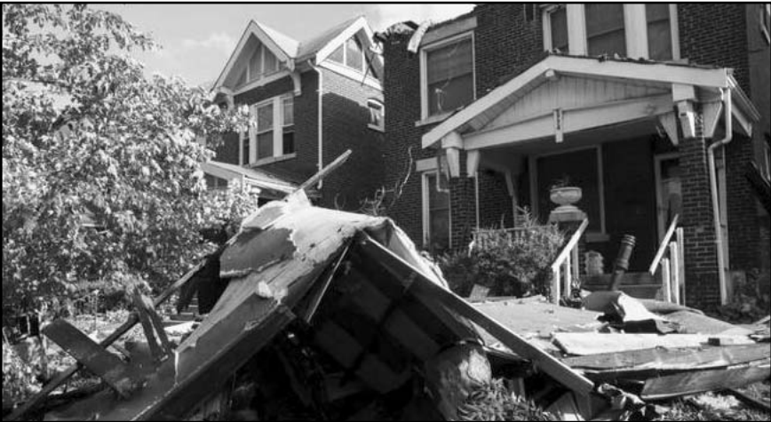
Un techo derrumbado en un patio delantero después de que los tornados arrasaran, dañando casas y esparciendo escombros.
