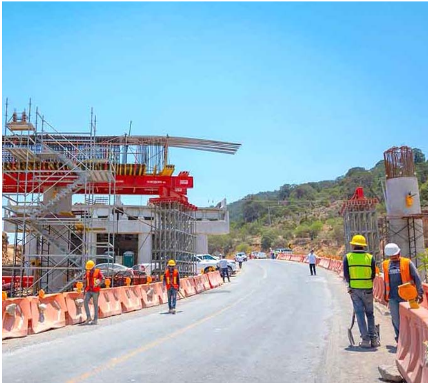
La nueva Carretera Interserrana permitirá agilizar los procesos de traslado de mercancías a exportadores locales y nacionales.
