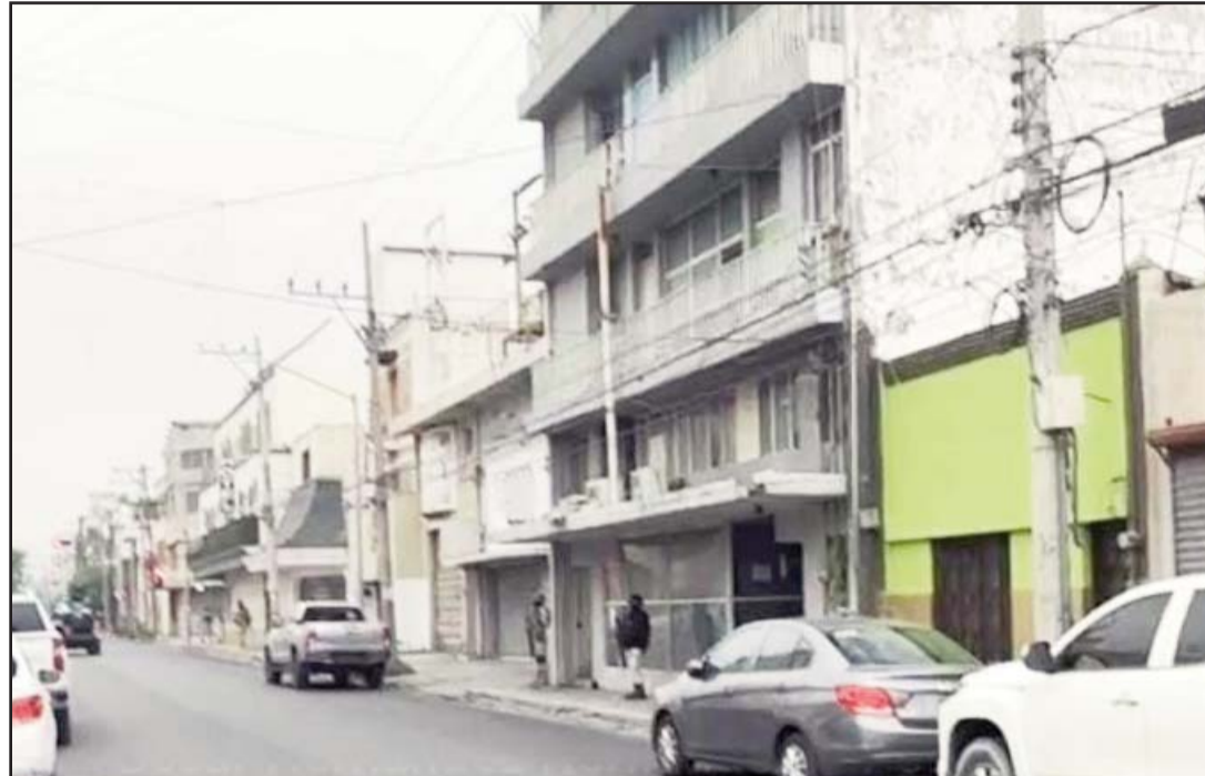
El edificio está ubicado en Reforma, entre Zuazua y Zaragoza, en el centro de la ciudad.
