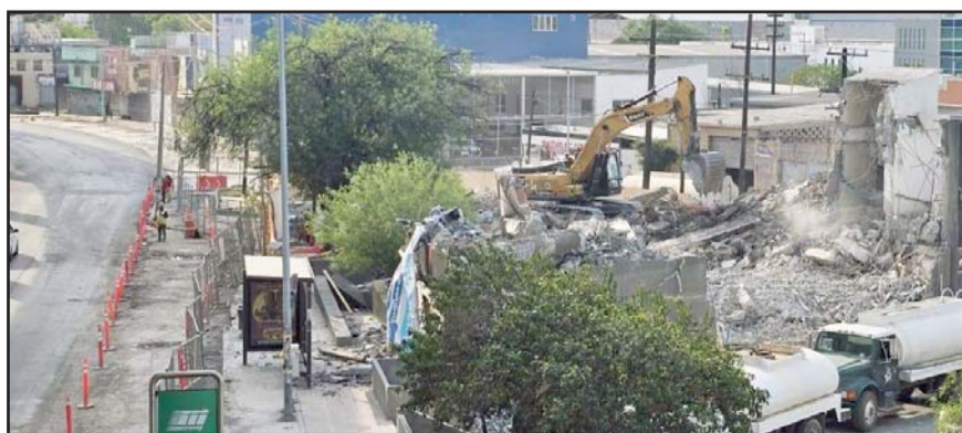
Será a un costado de la estación Y, en donde se empezó con el derrumbe de locales.
