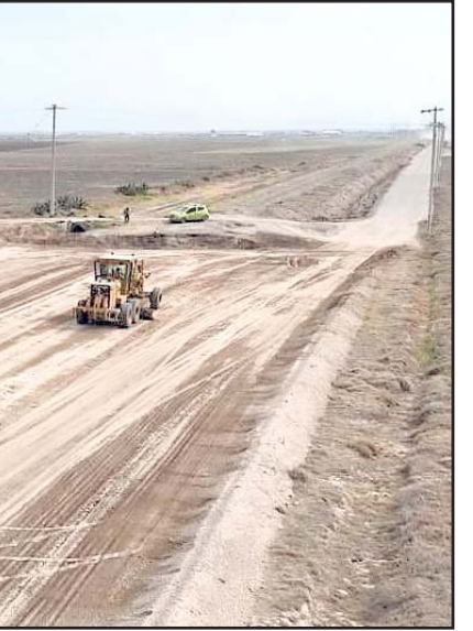
La mandataria federal compartió imágenes del avance en la obra ferroviaria.
