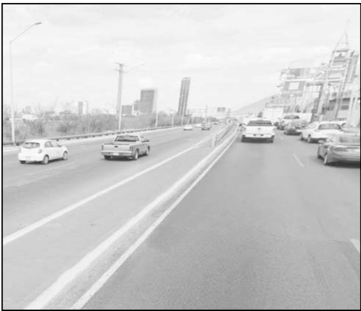
El cierre es debido a la reparación de un pluvial.
