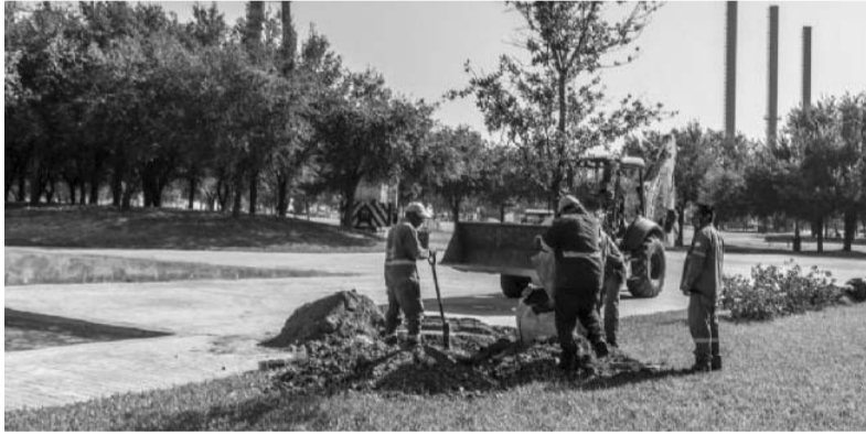
El Parque Fundidora ha sufrido severos daños.
