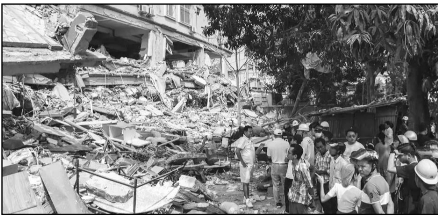
Un grupo de personas observa cómo los equipos de rescate intentan liberar a residentes atrapados bajo los escombros de un complejo de condominios.
