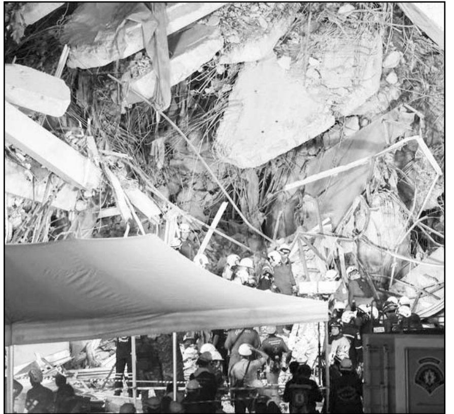
Rescatistas trabajan en el lugar del derrumbe de un edificio en Bangkok, Tailandia, tras el fuerte terremoto que azotó Myanmar
