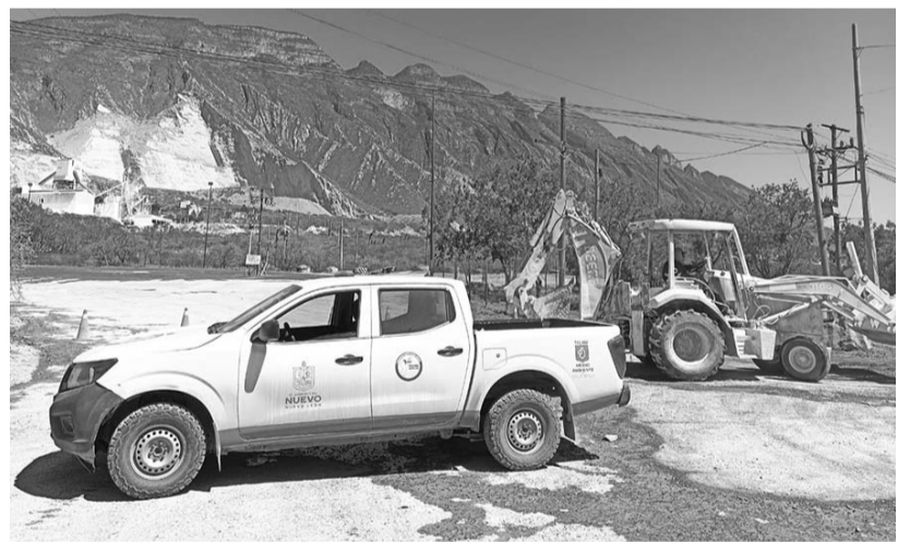
La Secretaría de Medio Ambiente suspendió las actividades de una empresa en el municipio de Pesquería y una obra en construcción en Santa Catarina, entre otras acciones.
