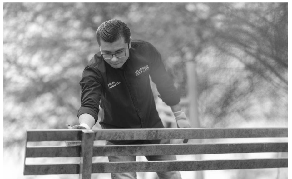
El alcalde de Juárez, Félix Arratia Cruz encabezó el arranque de los trabajos de rehabilitación y mantenimiento de cinco parques de la colonia Praderas del Oriente.
