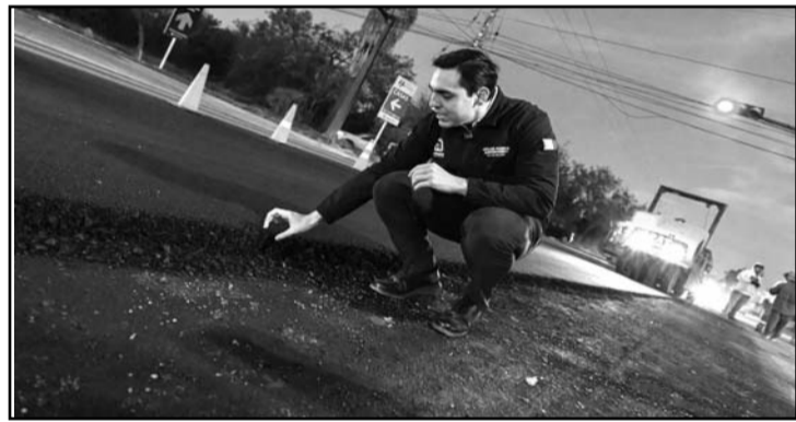
El alcalde César Garza Arredondo acudió a supervisar la obra
