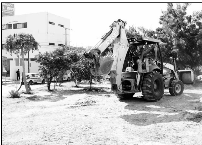
La idea es construir un parque en el terreno ubicado en Las Puentes
