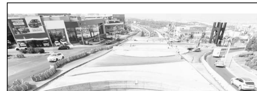
Se trata de un paso a desnivel en el mencionado cruce.
